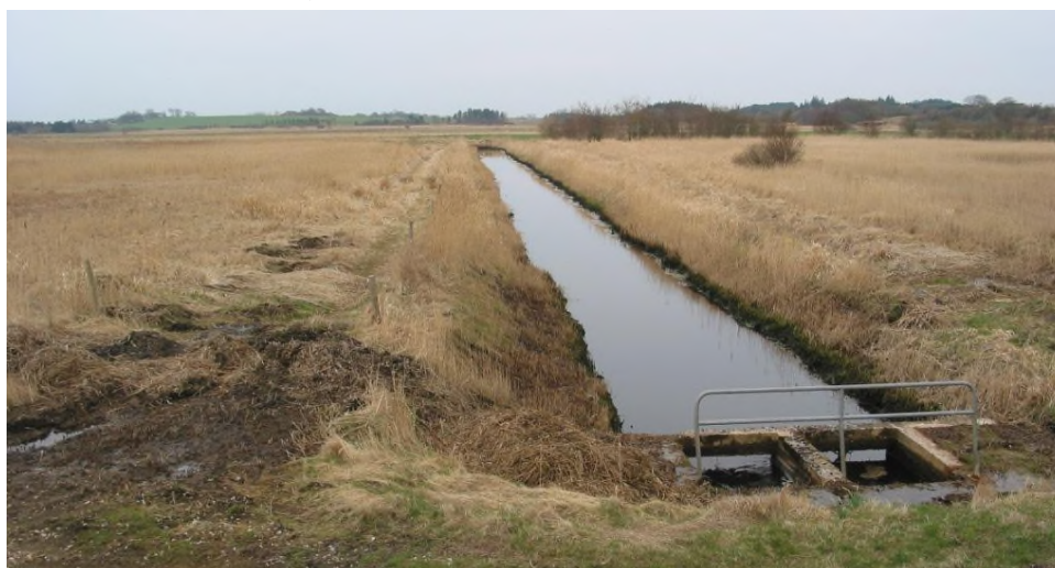
SILLERSLEV Å SET MOD VEST FRA PUMPESTATIONEN (PUMPESTATION 1)
